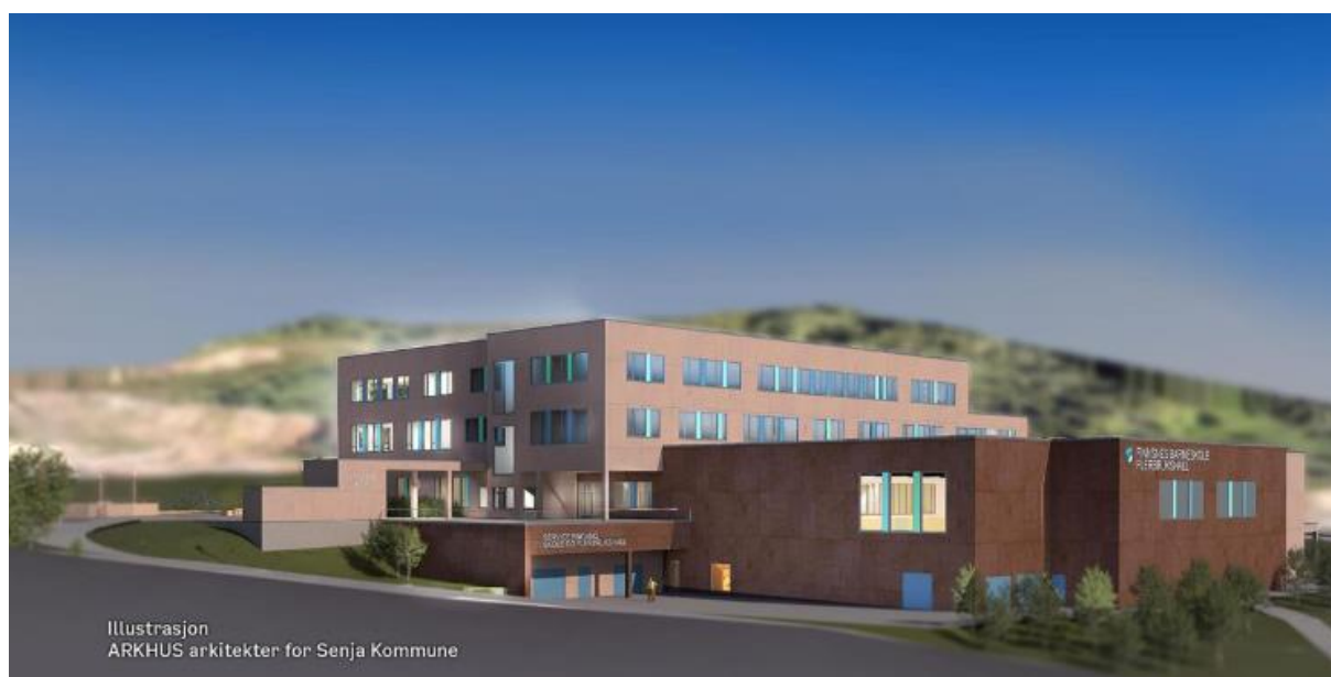
Nye Finnsnes barneskole. Ferdig senhøstes 2025
