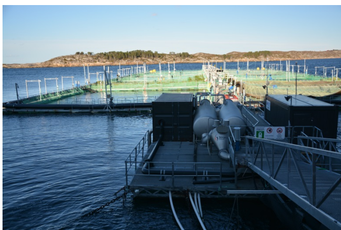
Figur 1 - Laks til prosessering og forsøk ble tatt ut fra Ventemerd 2 som er andre ventemerd i rekken på venstre side i bildet. Bildet viser også plasseringen av de doble trykk/vakuumpumpene som forsyner slakteriet med fisk. I brakken til høyre for pumpen styres og overvåkes trengeprosessen.
