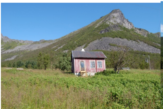
Barbogen. Eldre hus
