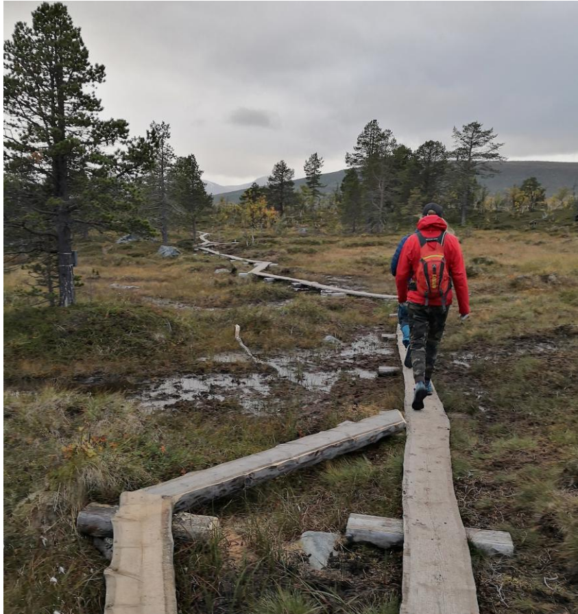
Figur 8. Tilrettelegging av sti kan føre til uforutsette konsekvenser, slik som i dette tilfellet av klopping der turgåere gikk ut i myra ved passering. Eksempel fra sti til Blåisvatnet, Lyngen kommune. Foto: Frida Omma.
