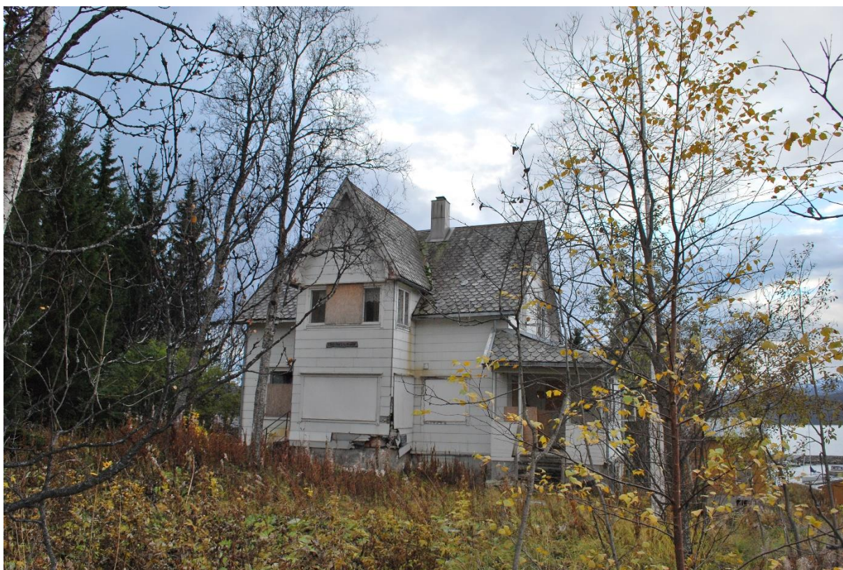
Gamle Seljestadgård, totalskadet i brann
