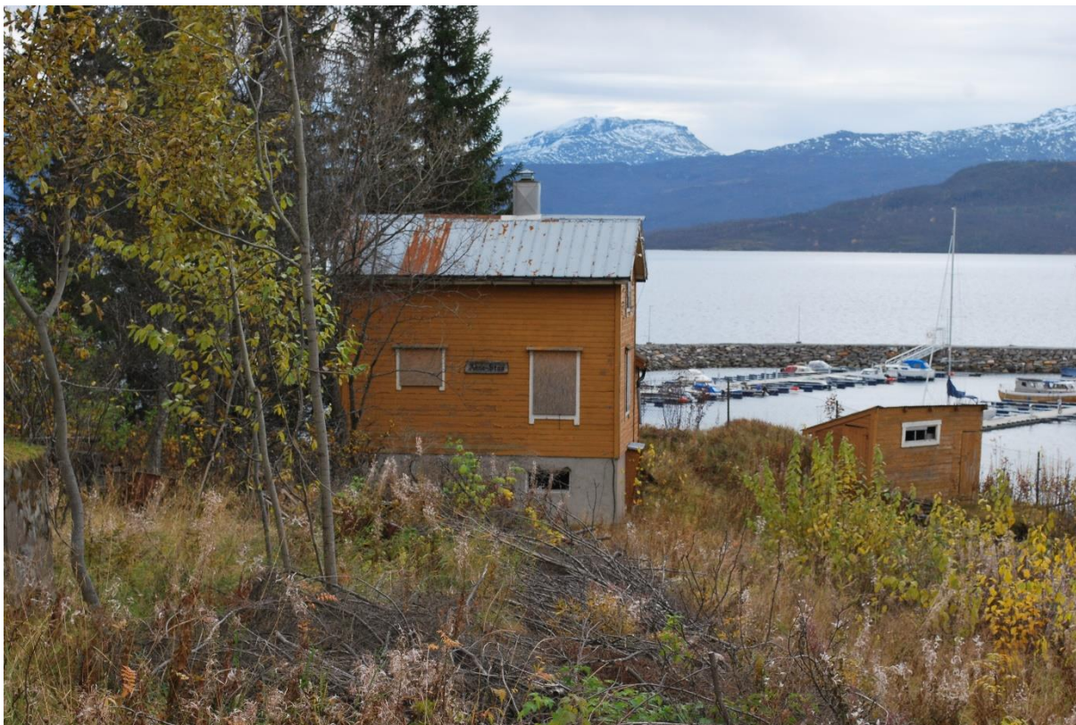
Anna-stua, i dårlig tilstand
